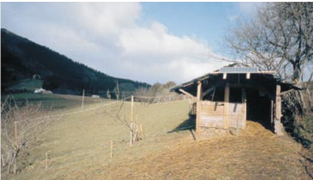
Figura 56. Instalación fotovoltaica de conexión a red.
