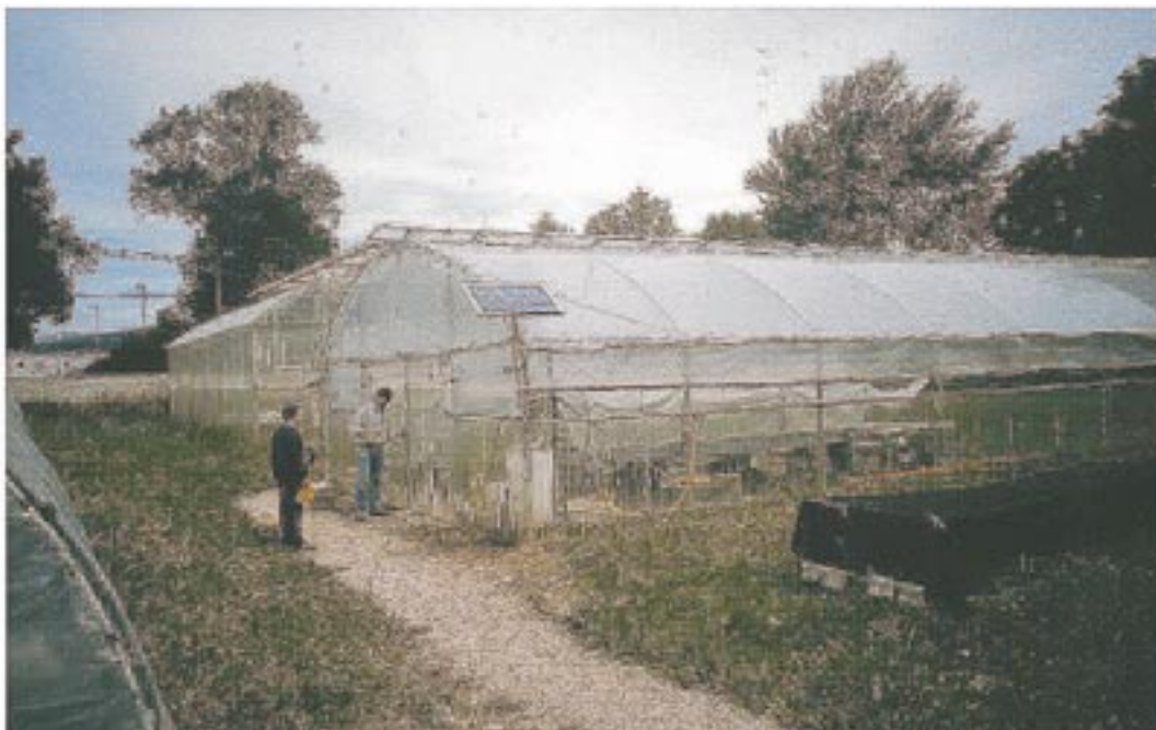
Figura 51. Invernadero con un dosificador de abono fotovoltaico.
