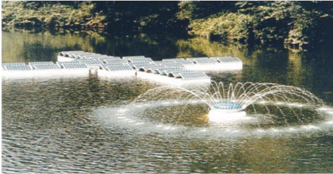
Figura 28. Bombeo directo en un estanque para decoración y oxigenación del agua.
