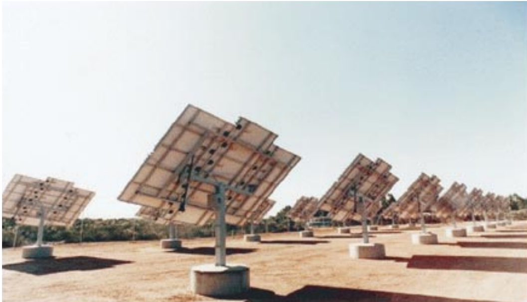
Figura 43. El heliostato (seguidor del sol) consigue en cada momento máxima captación.
