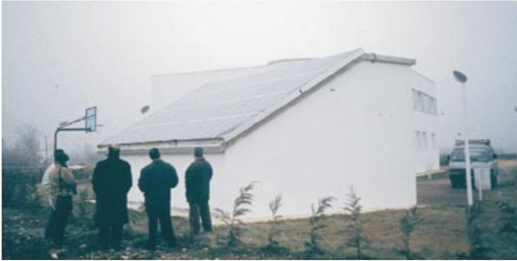
Figura 56. Instalación fotovoltaica de conexión a red.
