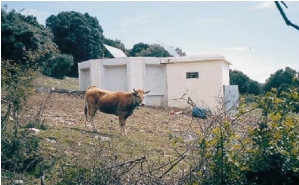
Figura 55. Bombeo de agua potable.
