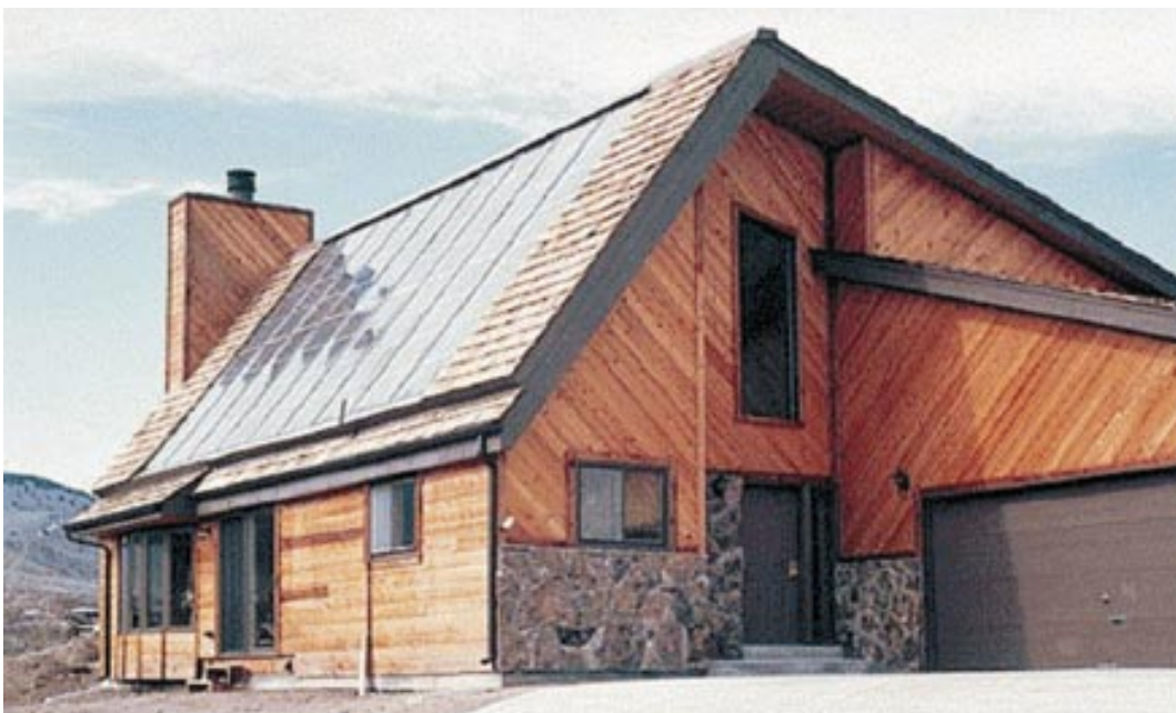
Figura 23. Ejemplo de instalación fotovoltaica integrada en el tejado de una vivienda.
