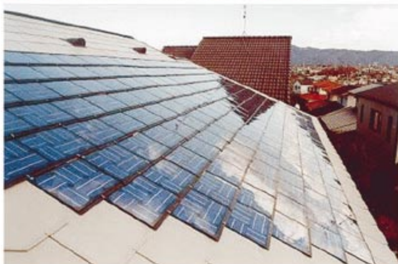
Figura 39. Tejas fotovoltaicas para la integración en tejado de la superficie colectora.
