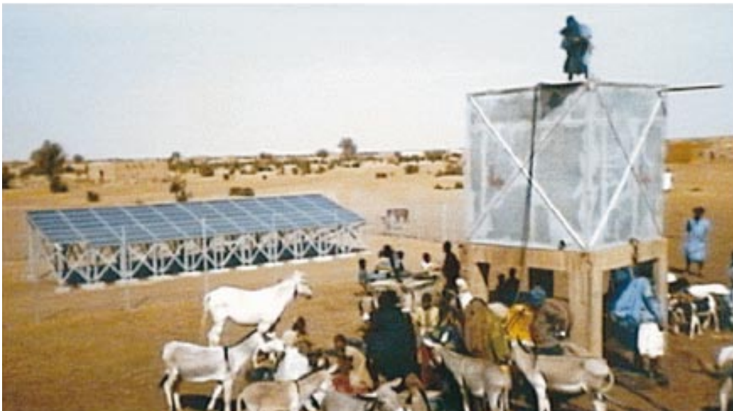
Figura 40. Instalación fotovoltaica para suministro de agua potable en un poblado.
