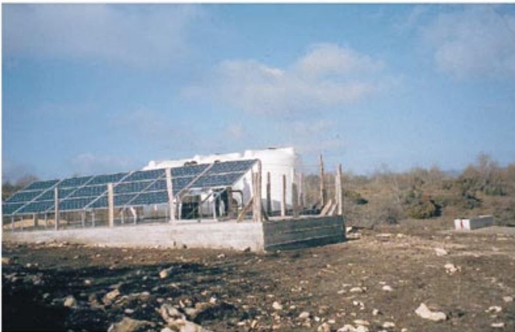
Figura 52. Bombeo directo para suministro de agua para ganado.
