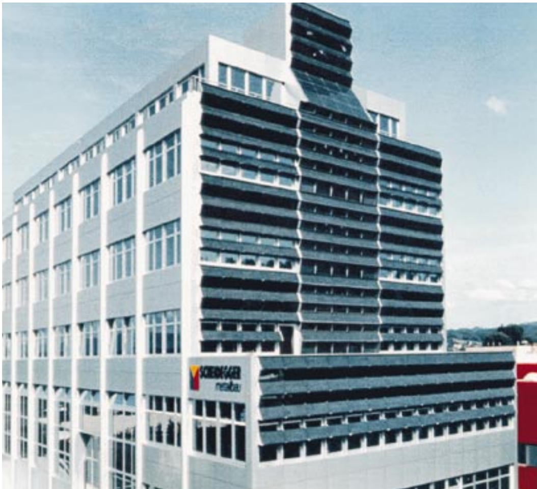
Figura 36. Instalación fotovoltaica de conexión a red integrada en la fachada de un edificio
