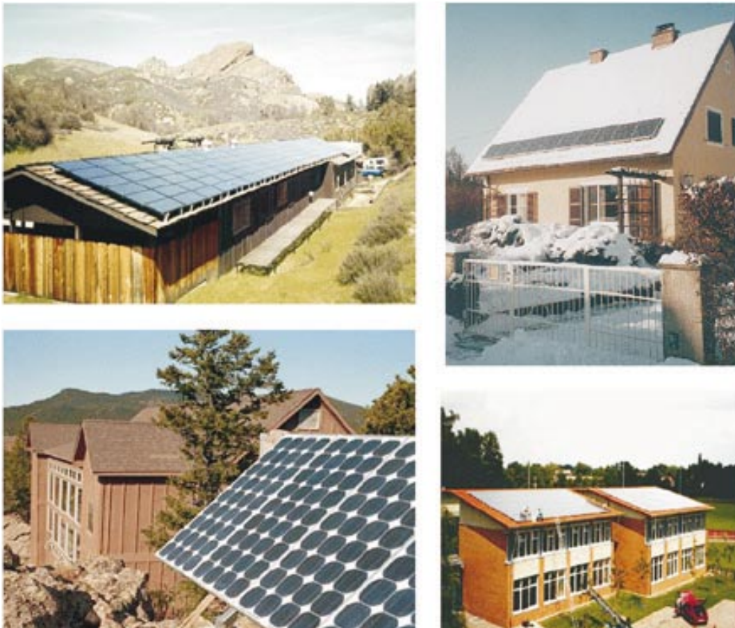
Figura 26. Diversos ejemplos de instalaciones fotovoltaicas.
