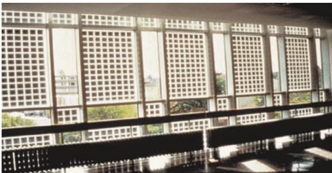
Figura 37. Utilización de células semitransparentes para su integración en ventanas.
